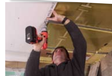
Vissage de la plaque au droit des ossatures
